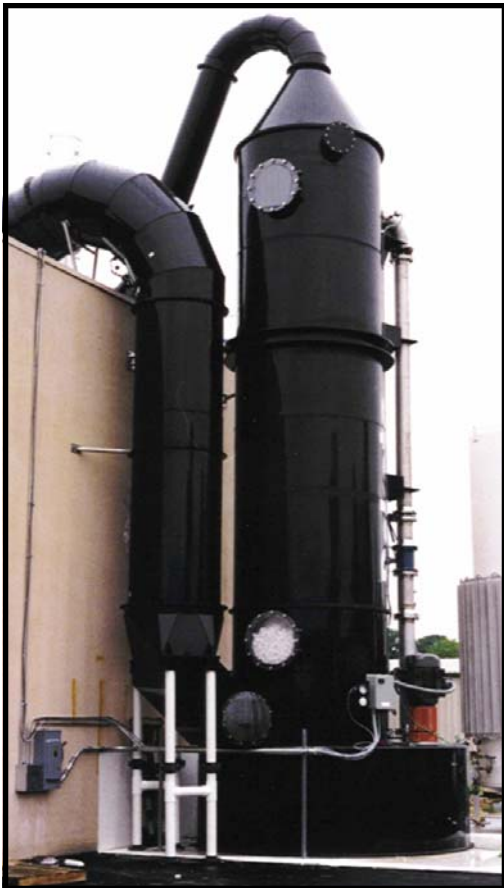
10,000 ACFM Dakota Scrubber™ éliminant les émissions de triéthylamine (TEA) du procès du noyaux froids de gaz d'uréthane phénolique.
