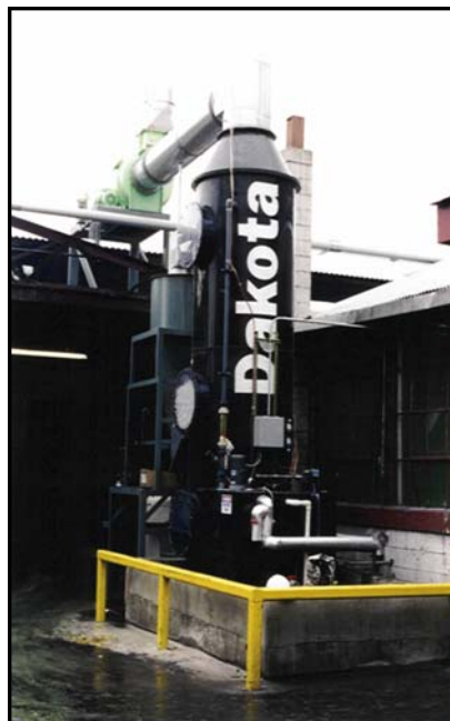
5,000 ACFM Dakota Scrubber™ éliminant les émissions de triéthylamine du procédé des noyaux de gaz d'uréthane phénolique.
